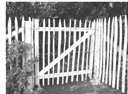
Torrahmen aus Lärchenkantholz mit befestigtem Zaunstück, Höhe 100 cm - 4 cm Zwischenraum
